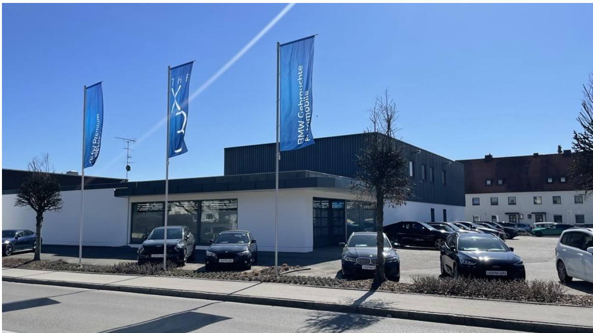
Neue Werkstattfläche und Außenanlage am Standort Neuburg
